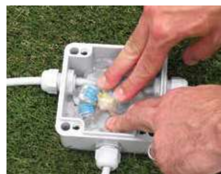
Ricoprire le connessioni, facendo attenzione a non lasciare zone di vuoto tra i contatti
