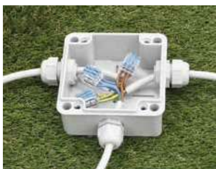
Cablare i cavi nella scatola di derivazione
